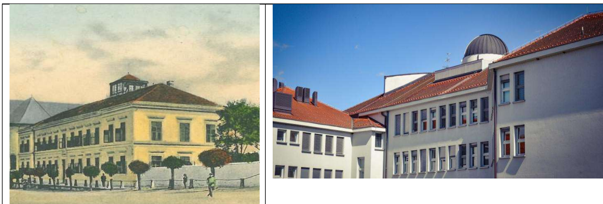
Sl.18. Svjetlarnik na krovu stare i zvjezdarnica na krovu nove zgrade Gimnazije
